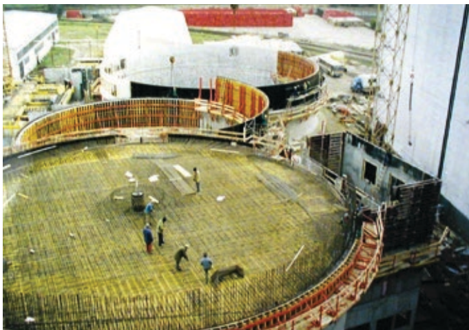
Fig. 6 Construction of new maltery in 2001 Obr. 6 Výstavba novej sladovne v roku 2001
