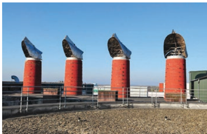
Fig. 3 Chimneys of the oldest original kilns Obr. 3 Komíny najstarších pôvodných hvozdo
