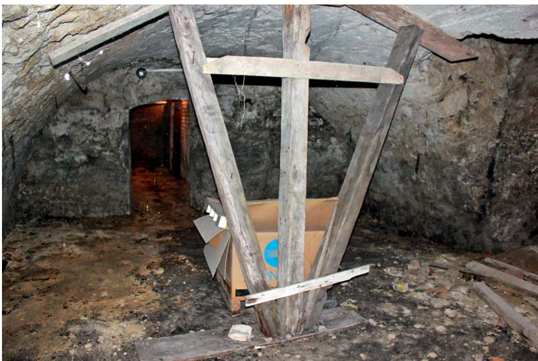
Obr. 3 Sklep bývalého obecního pivovaru s výtřevou v roce 2015 (Foto: autor)
