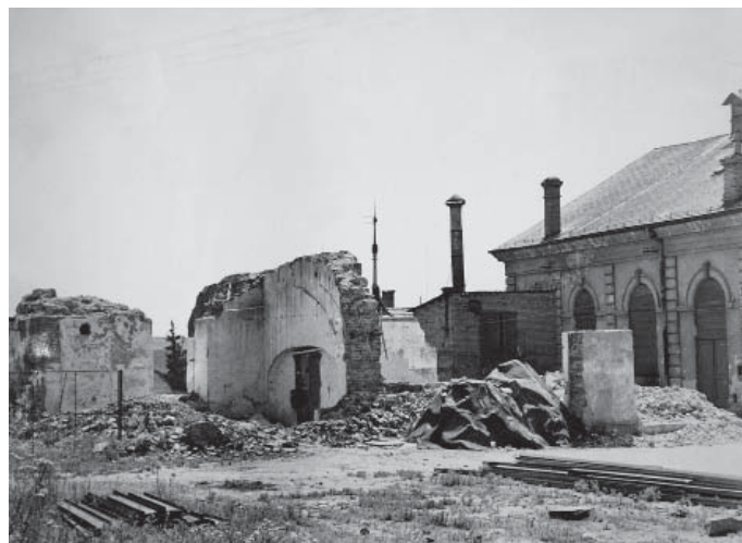
Obr. 5 Asanace sladovny pohledem ze Slezského náměstí v roce 1966 (SOKA, 397)
