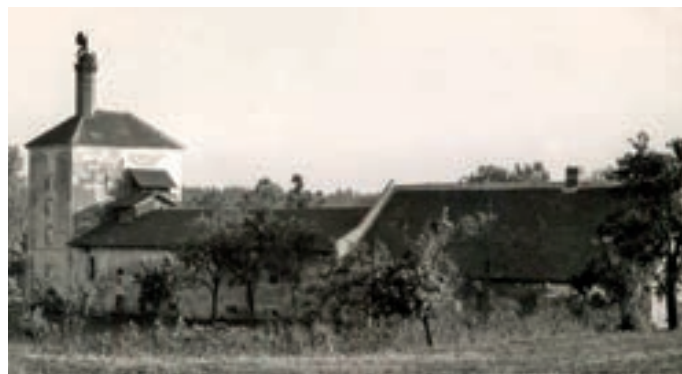
Obr. 6 Foto sladovny po přestavbě firmou Novák & Jahn, kde je zřetelný nový otočný párník (zdroj: archiv Jaroslava Musila)
