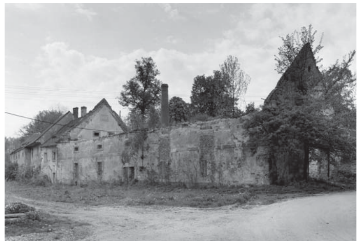
Obr. 1 Zahrádky pivovar, celkový pohled od severozápadu před rozsáhlejší demolicí, foto R. Kursy 2004 (archiv NPÚ, ÚOP v Liberci)
