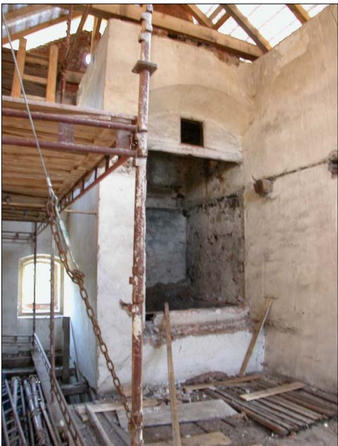
Obr. 22 Při rekonstrukci sladovny v Zahrádce v roce 2005
