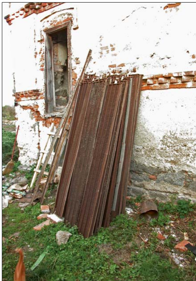
Obr. 23 Pohled na jednotlivé sklopné pásy lísek rozebraného hvozdu v roce 2005 (zdroj: archiv autora)
