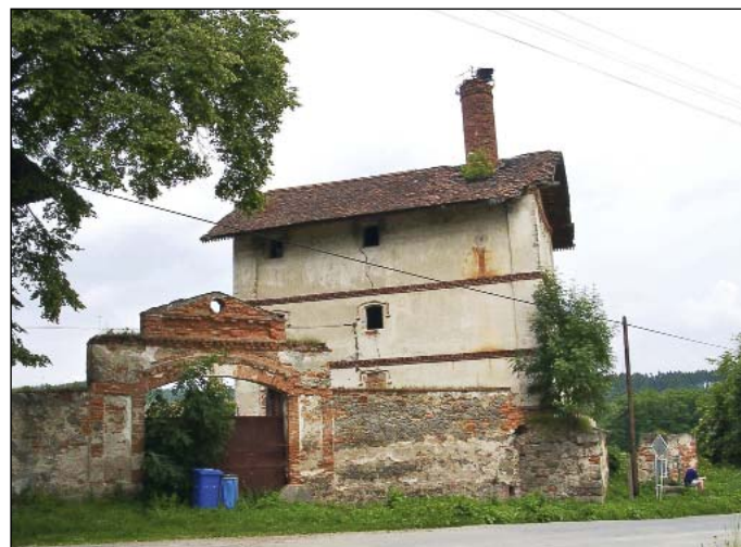
Obr. 20 Pohled na sladovnu v Zahrádkách u Sedlčan v roce 2002 (zdroj: archiv autora)
