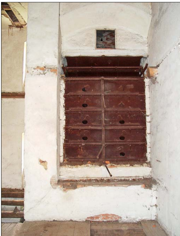
Obr. 21 Unikátně dochovaná technologie hvozdové pece systému Jana Ječmena v Zahrádce v roce 2002 (zdroj: archiv autora)
