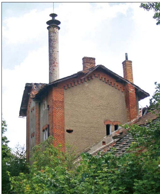
Obr. 14 Sladovna plavnického pivovaru v roce 2004 s netradičně vysokým a úzkým komínem byla taktéž osazena technologií Ječmenovy sušárny (zdroj: archiv autora)
